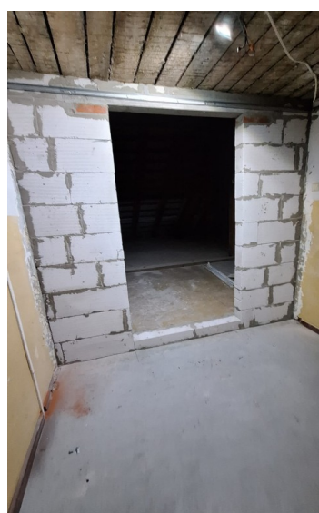
Fotografia 14: Prace remontowe w SP w Wielkim Rychnowie – II etap
