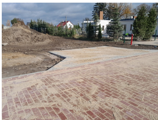
Fotografia 20: Prace remontowe WDK w Sierakowie
