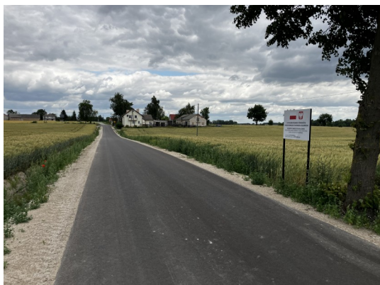
Fotografia 29: Nowa droga gminna w Chełmoniu
