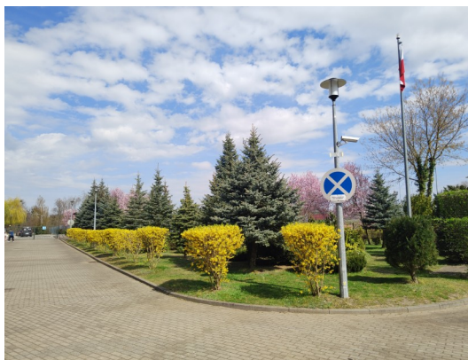
Fotografia 46: Wymienione oprawy oświetleniowe
