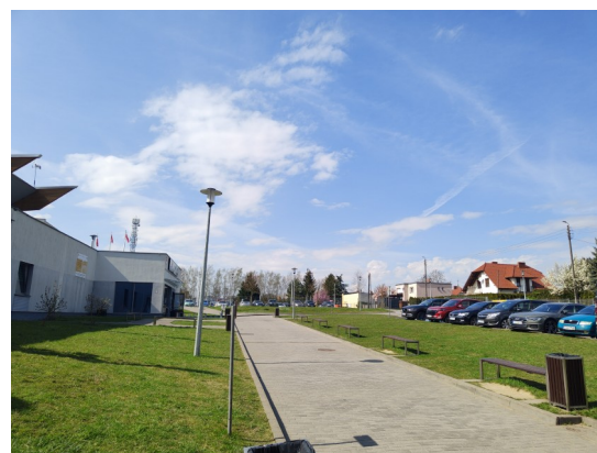
Fotografia 48: Wymienione oprawy oświetleniowe
