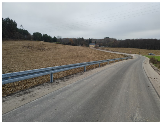
Fotografia 32: Nowa droga gminna w Pruskiej Łące
