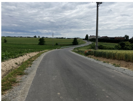
Fotografia 28: Nowa droga gminna w Bielsku
