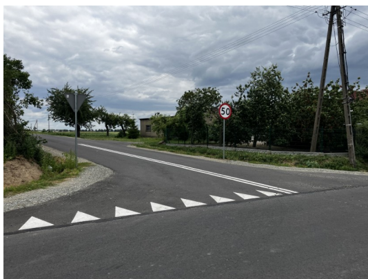
Fotografia 27: Nowa droga gminna w Bielsku
