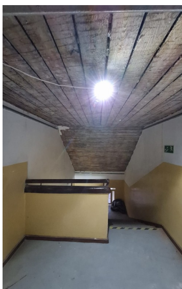
Fotografia 13: Prace remontowe w SP w Wielkim Rychnowie – II etap
