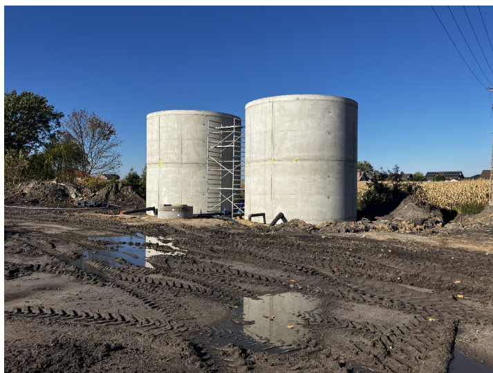
Fotografia 42: Prace remontowe przy zbiornikach retencyjnych
