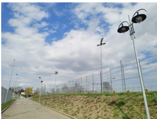
Fotografia 47: Wymienione oprawy oświetleniowe
