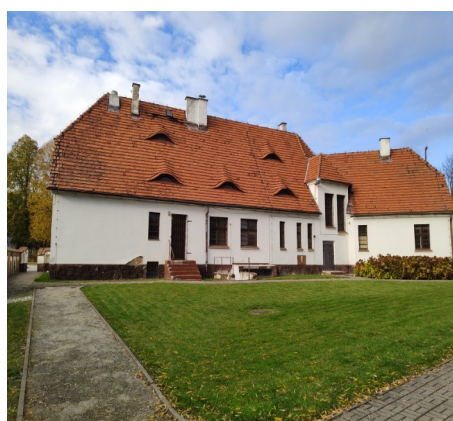
Fotografia 3: Obecny stan budynku zajazdu
