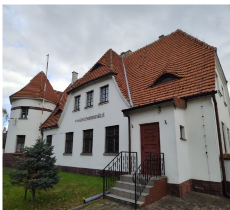
Fotografia 2: Obecny stan budynku zajazdu
