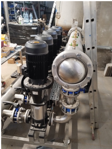
Fotografia 34: Prace remontowe na SUW w Wielkiej Łące
