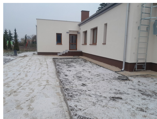
Fotografia 21: Prace remontowe WDK w Sierakowie
