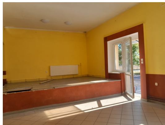
Fotografia 19: Prace remontowe WDK w Sierakowie
