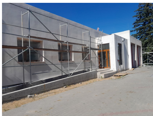
Fotografia 22: Prace remontowe WDK w Sierakowie
