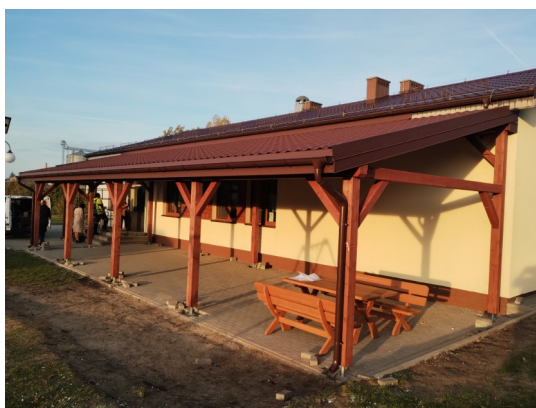
Fotografia 26: Prace remontowe przy Domu Kultury w Piątkowie
