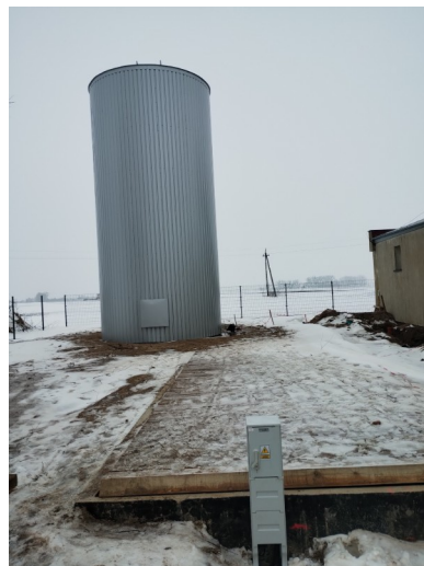
Fotografia 35: Prace remontowe na SUW w Wielkiej Łące
