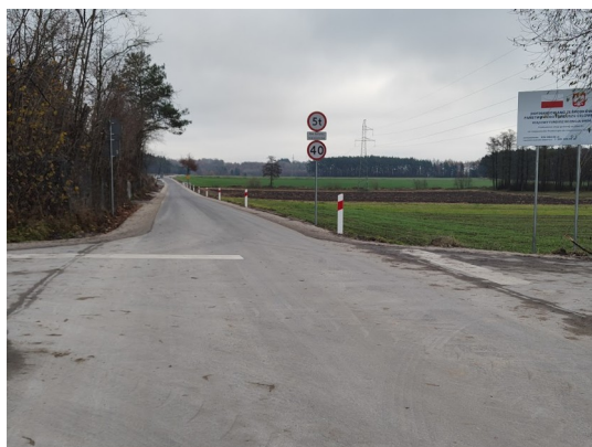
Fotografia 31: Nowa droga gminna w Pruskiej Łące
