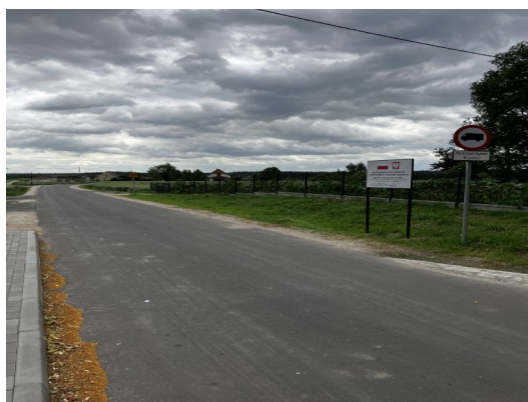
Fotografia 30: Nowa droga gminna w Chełmoniu
