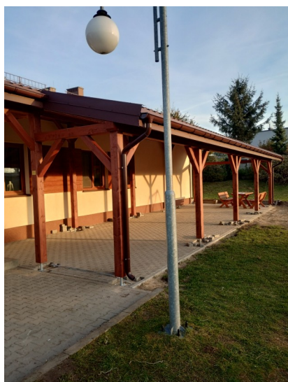
Fotografia 24: Prace remontowe przy Domu Kultury w Piątkowie
