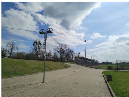
Fotografia 45: Wymienione oprawy oświetleniowe
