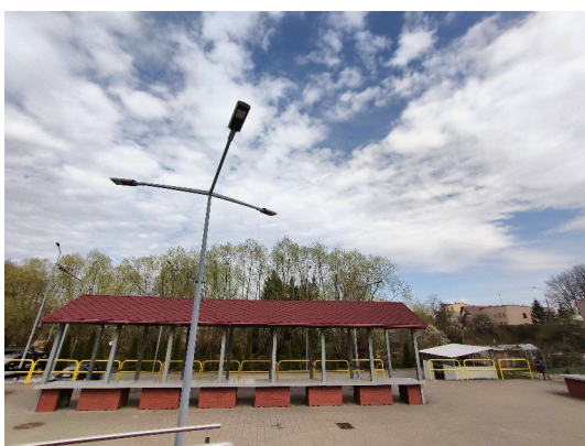
Fotografia 49: Wymienione oprawy oświetleniowe
