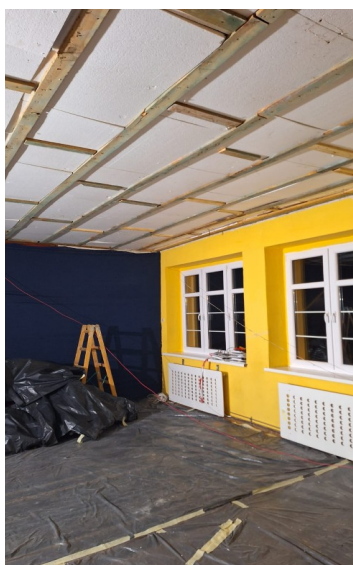
Fotografia 12: Prace remontowe w SP w Wielkim Rychnowie – II etap
