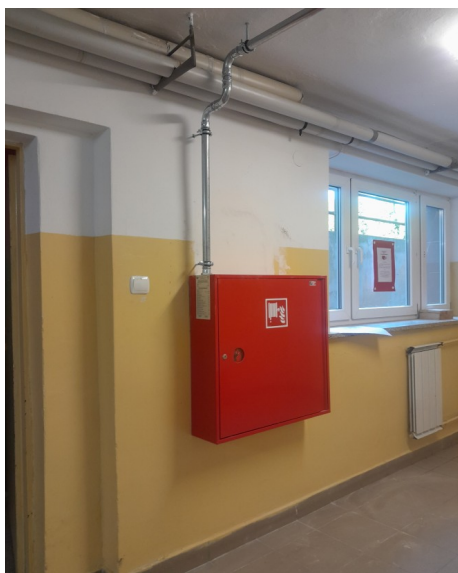
Fotografia 10: Prace remontowe w SP w Wielkim Rychnowie – I etap
