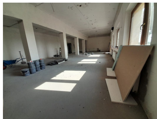
Fotografia 23: Prace remontowe WDK w Sierakowie
