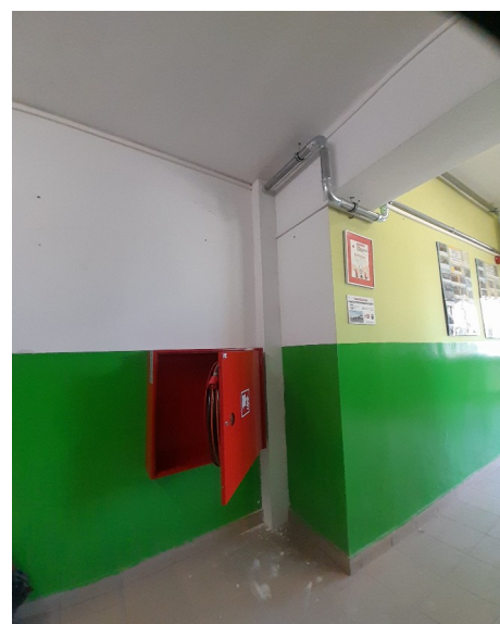
Fotografia 11: Prace remontowe w SP w Wielkim Rychnowie – I etap
