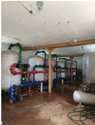
Fotografia 33: Prace remontowe na SUW w Wielkiej Łące
