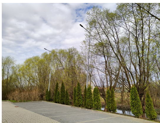
Fotografia 50: Wymienione oprawy oświetleniowe
