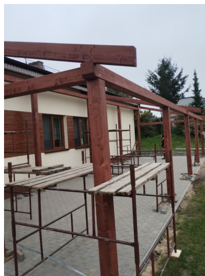
Fotografia 25: Prace remontowe przy Domu Kultury w Piątkowie
