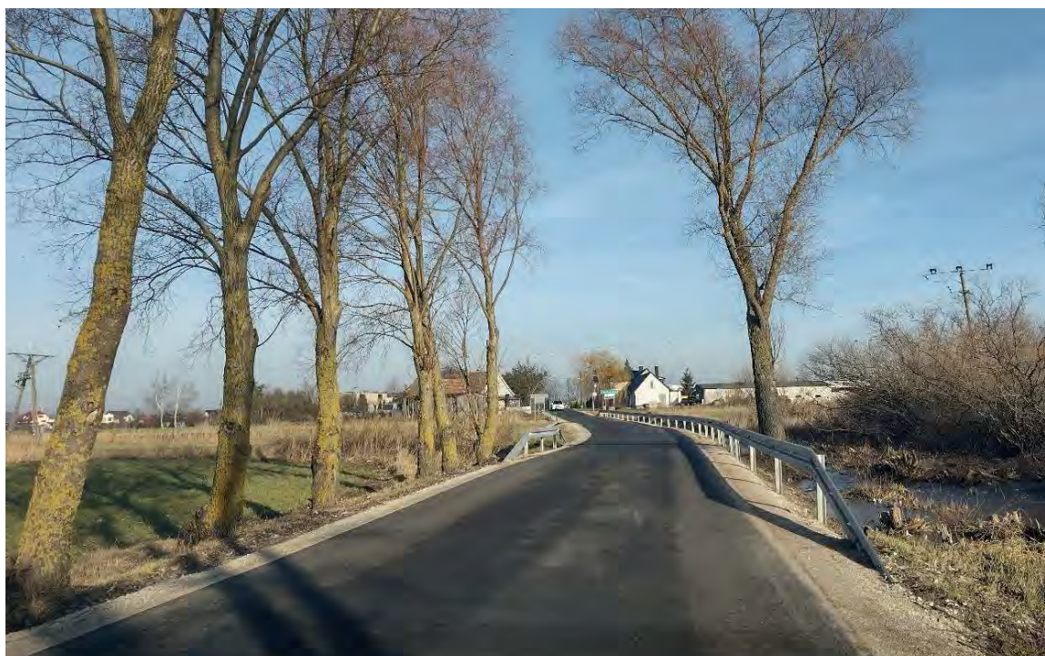
Fot. 5: Remont drogi gminnej nr 110136C relacji Kowalewo Pomorskie – Szychowo
