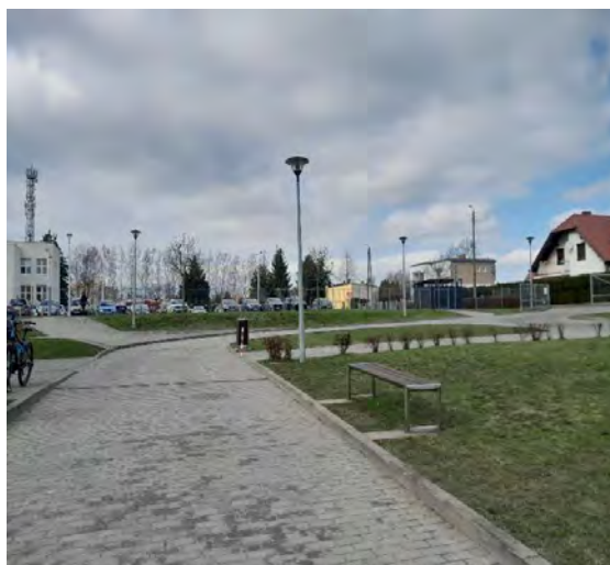
Fot. 44: Stan oświetlenia przed przystąpieniem do modernizacji
