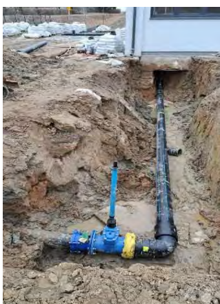
Fot. 39: Stacja Uzdatniania Wody w Marianach w trakcie modernizacji
