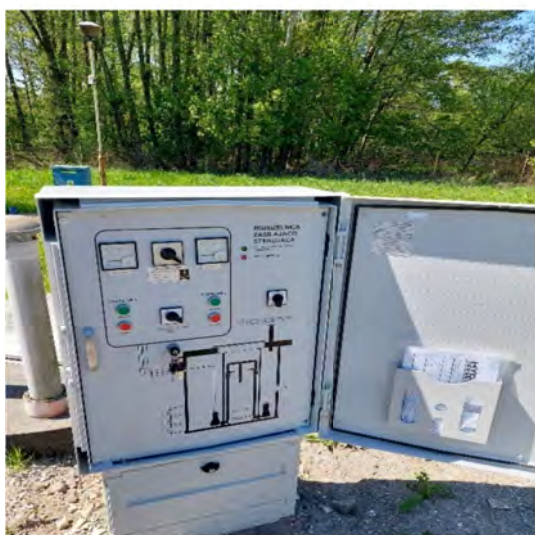
Fot. 41: Modernizacja gospodarki osadowej III etap
