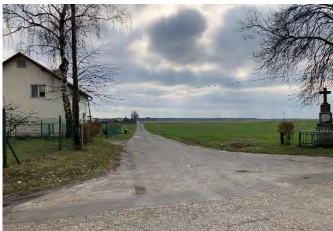
Fot. 30: Stan dróg gminnych w miejscowości Chlemonie przed rozpoczęciem inwestycji
