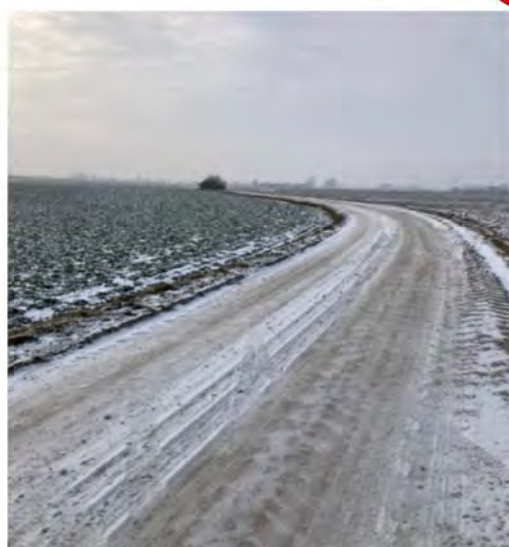
Fot. 28: Stan drogi gminnej w Bielsku przed rozpoczęciem inwestycji
