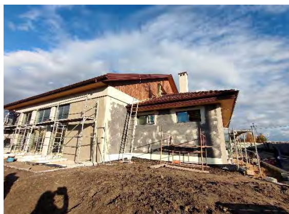
Fot. 14: Centrum kultury i integracji społecznej w Wielkiej Łące w trakcie budowy
