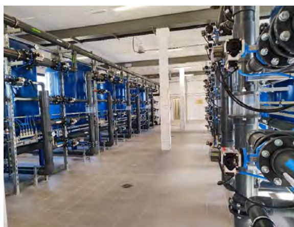
Fot. 38: Stacja Uzdatniania Wody w Piątkowie po zakończeniu modernizacji
