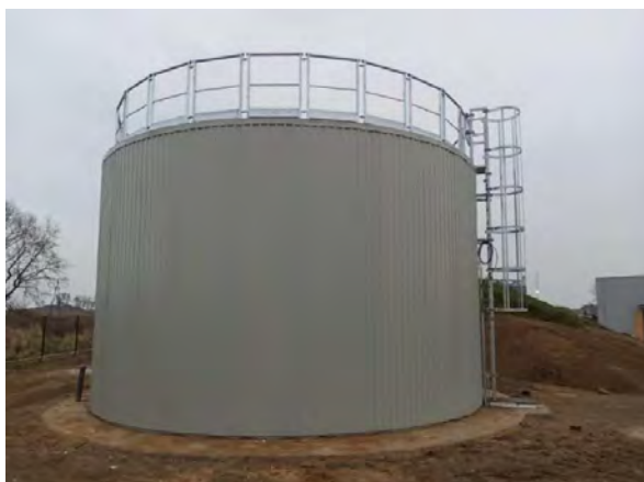
Fot. 37: Stacja Uzdatniania Wody w Piątkowie po zakończeniu modernizacji
