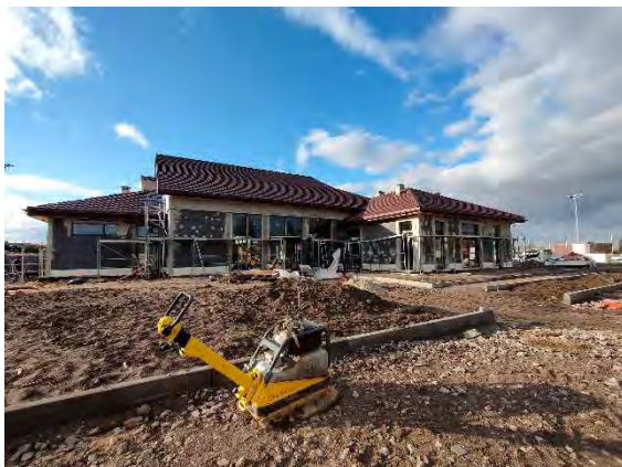
Fot. 13: Centrum kultury i integracji społecznej w Wielkiej Łące w trakcie budowy
