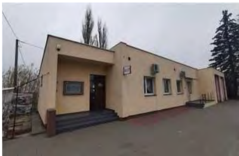
Fot. 25: Elewacja budynku świetlicy w Sierakowie - stan przed remontem
