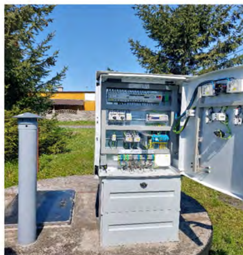
Fot. 42: Modernizacja gospodarki osadowej III etap
