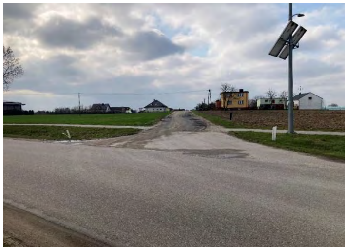
Fot. 29: Stan drogi gminnej nr 110167C w m. Bielsk przed rozpoczęciem inwestycji
